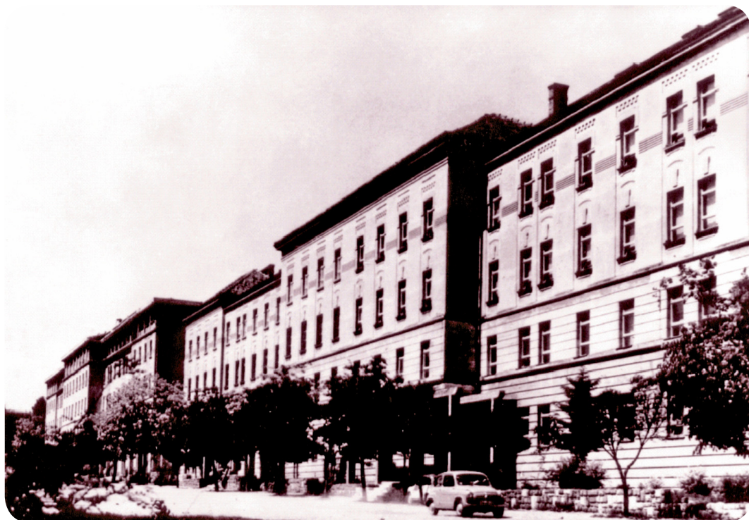
Pročelje zgrade Strojarskog fakulteta u Rijeci 1963. godine / The edifice of the Faculty of Engineering in Rijeka in 1963
